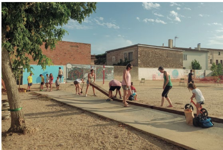
Obres de remodelació del pati de l'escola.
