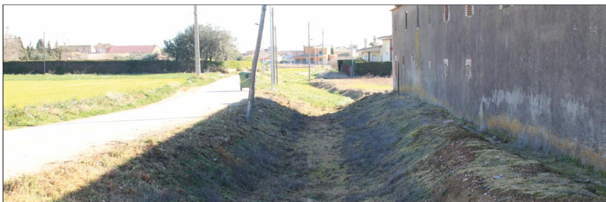
Figura 02. Vista W-E del tram d'escòrrec afectat. Font: Geoservei, 2017.
