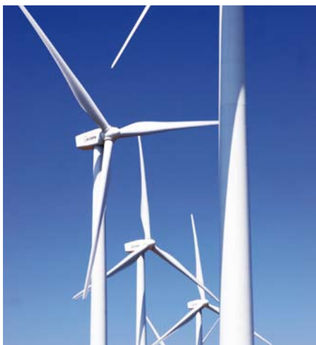
El parc eòlic representaria la instal·lació de deu molins aerogeneradors d'uns 120 metres d'alçada total i 90 metres de diàmetre de pales.
